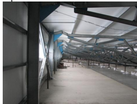
Рис. 5. Разрушение колонн в нижней части в средних пролётах здания и в середине колонны во второй от края колонне
