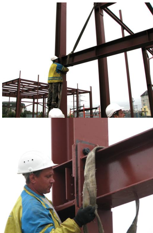
Рис. 7. Монтаж балок перекрытия на высокопрочных болтах
